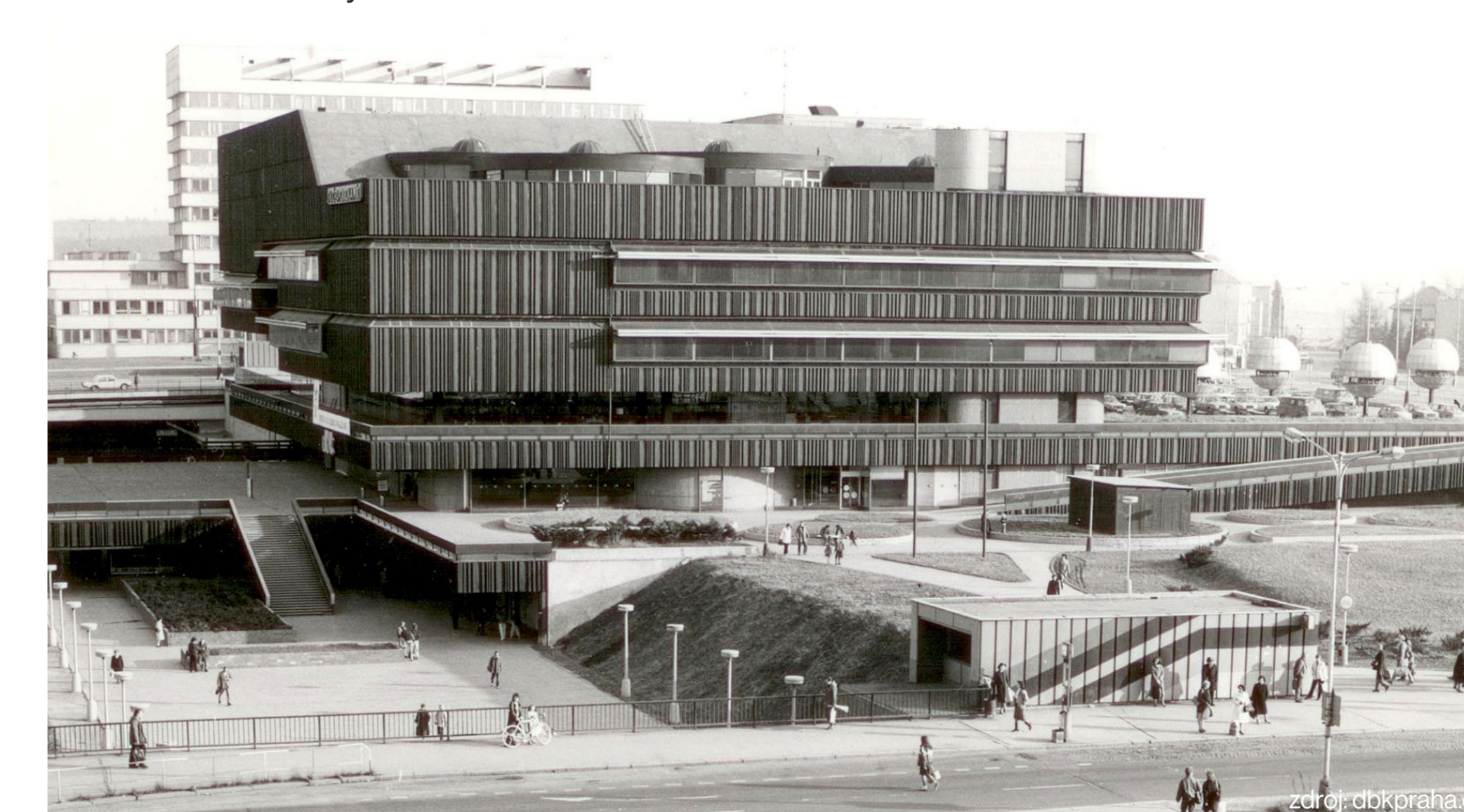
Obchodní dům DBK v roce 1983, stavba je příkladem brutalistní architektury.
