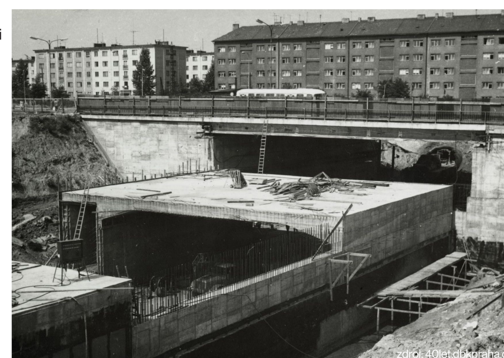
Stavba linky metra C, pohled směrem k ulici Olbrachtova, 1971
