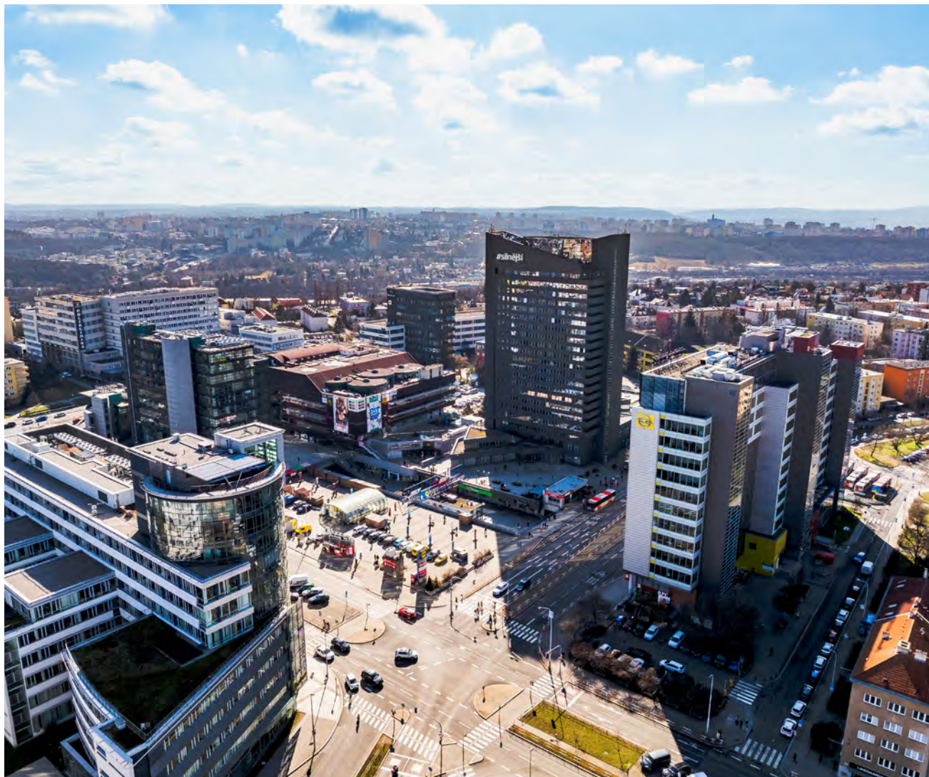
Obrázek 63 Administrativní budovy České spořitelny, vpravo na fotce kancelářská budova The Square, zdroj: Penta Real Estate
