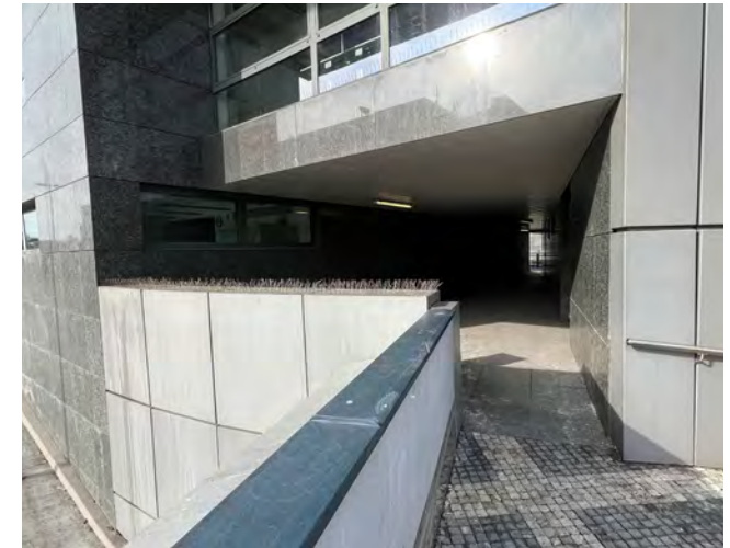
Obrázek 73 Průchod objektem na nároží ulic Budějovická a Antala Staška, autor: ONplan, 2026
