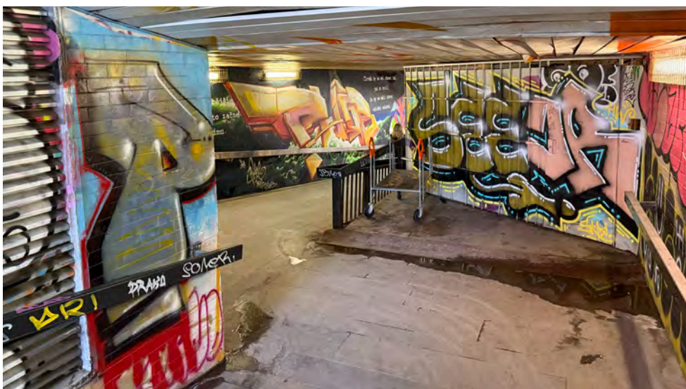
Obrázek 42 Přístupová rampa z ulice Antala Staška do obchodní pasáže v 1. podzemním podlaží, autor: ONplan, 2026
