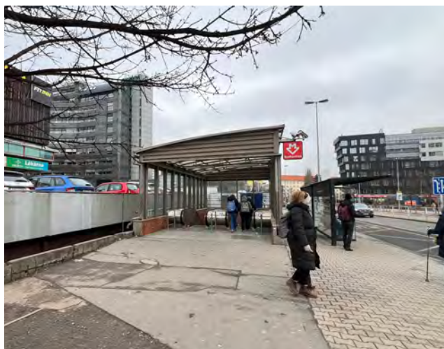
Obrázek 67 Přístřešek výstupu z obchodní pasáže v 1. podzemním podlaží na zastávku Poliklinika Budějovická, v ulici Antala Staška, autor: ONplan, 2026
