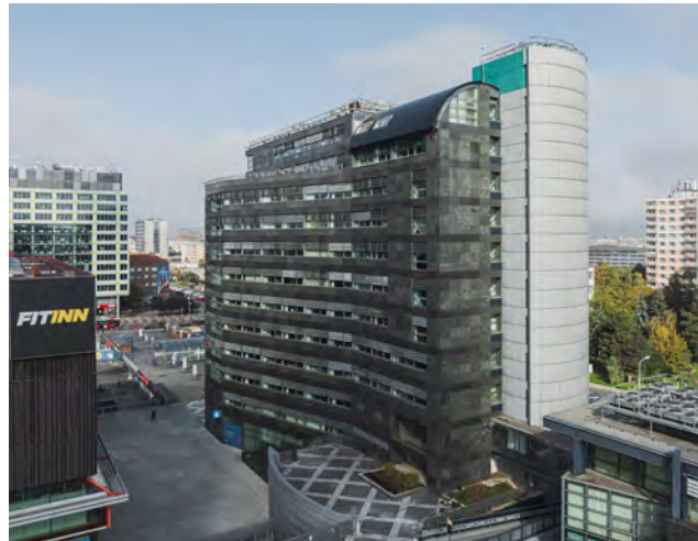
Obrázek 28 Administrativní budova České spořitelny Budějovická 1912/64b od Pavly Kordovské. V popředí nižší část komplexu na rohu ulic Antala Staška a Budějovická, zdroj: Penta Real Estate
