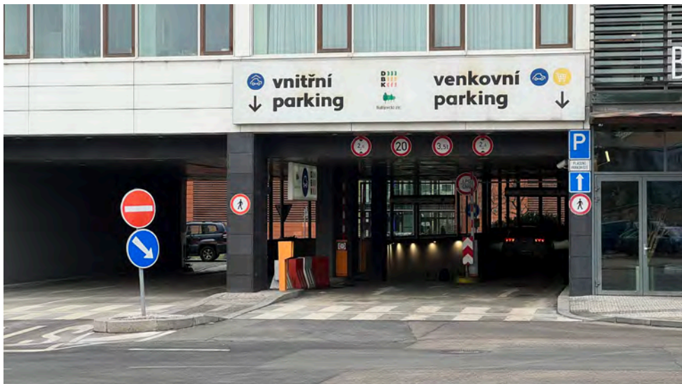
Obrázek 85 Vjezd do objektu Budějovická alej, a přes něj na vnitřní povrchové parkoviště u DBK, autor: ONplan, 2026
