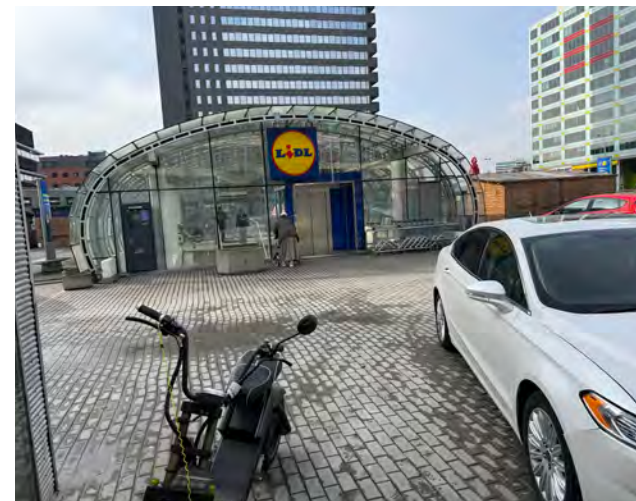
Obrázek 79 Fotografie vstupu do objektu Lidl s výtahem z parkoviště na nároží ulic Budějovická a Olbrachtova, který zajišťujících bezbariérové propojení mezi obchodní pasáží v 1. podzemním podlažím a uličním prostranstvím na povrchu, autor: ONplan, 2026
