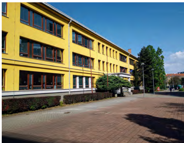
Obrázek 36 Hlavní vchod do budovy Základní školy v ulici Poláčkova, autor: ONplan, 2026
