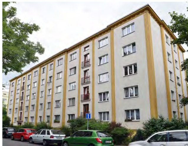
Obrázek 38 Dostavba sídlíšti Zelená liška z 50. let, první panelové domy v Praze ve stylu sorela, zdroj: TN CZ, Paneláková NEJ Česka, tn.nova.cz
